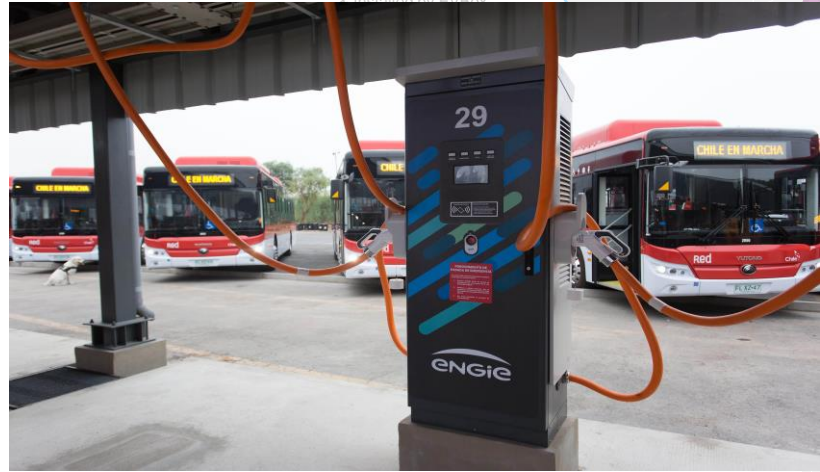
Servicio integral 100 buses 100% eléctrico Transantiago + Bus piloto urbano Solución de carga (150kW)
